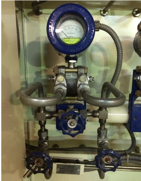
شکل ۷: ترانسمیتر اختلاف فشار دبی سنج اریفیس
